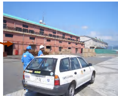
上屋・岸壁等の損傷確認
