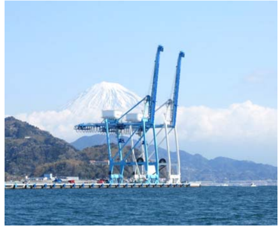
第2バースに据付されたクレーン
