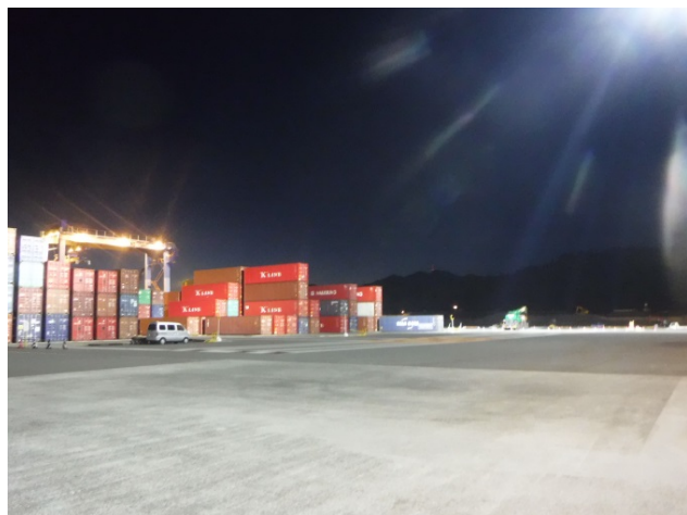
埠頭内を明るく照らすLED照明
