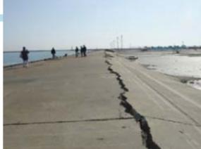
写真① エプロン沈下
