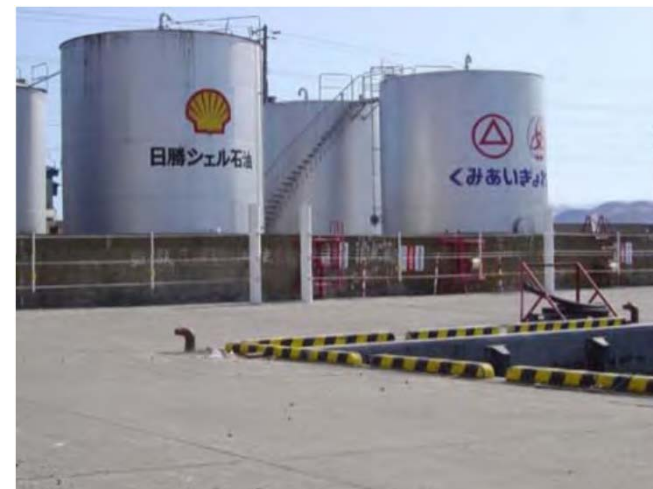
十勝港の漁港区の危険物タンク周辺の漂流物対策施設
